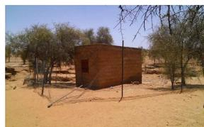
Le système a été mal conçu, le château situé dans un bas fonds à 1km du village, la pression faible dans le réseau.
